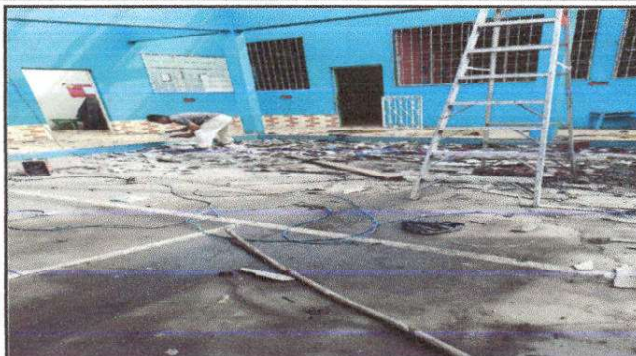
Foto 2: Trabajo de desmontaje del techo antiguo
