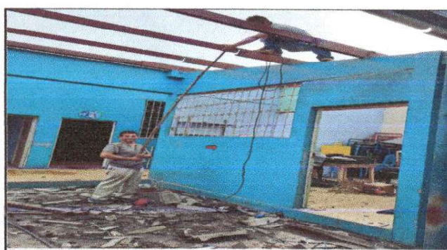
Foto 6: Pintura de costaneras
