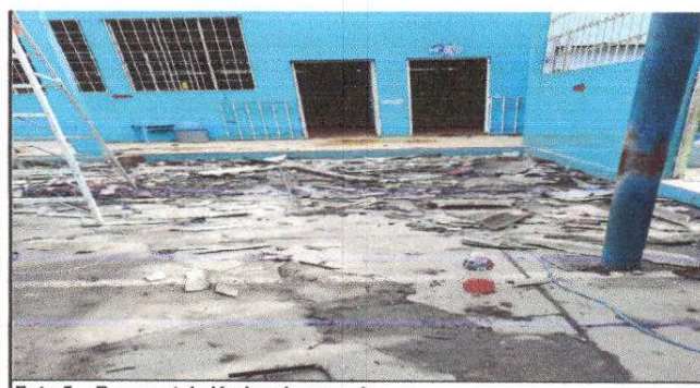
Foto 5: Desmontaje lámina de corredor
