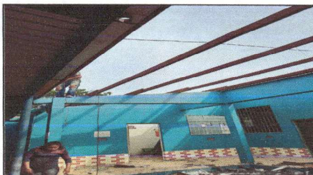
Foto 4: Nivelación de costaneras
