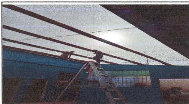
Foto1: Trabajo de mantenimiento de costaneras
