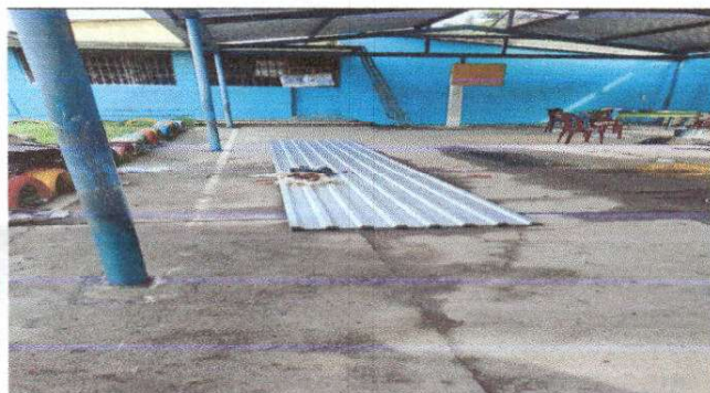
Foto 3: Desmontaje de techo viejo
